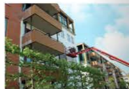
Er wordt vanuit meerdere hoogwerkers tegelijk gestaan.
