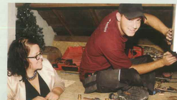
Angel van den Elshout kijkt hoe haar nieuwe cv ketel geïnstalleerd wordt
