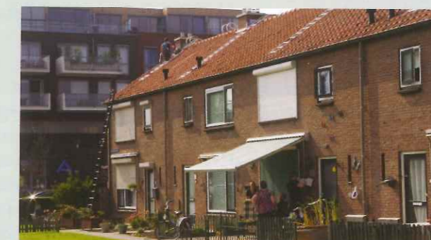
Werkzaamheden aan het dak
