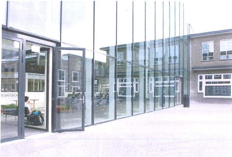
Het glas biedt een fraai contrast met het metselwerk van het oude Natlab.
