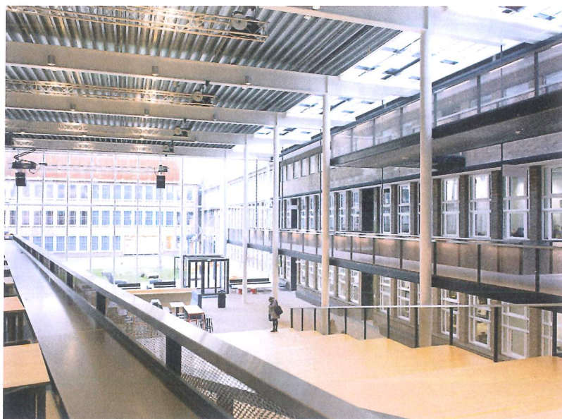
De oorspronkelijke buitengevel van het oude pand werd in de nieuwe constructie een binnengevel.
