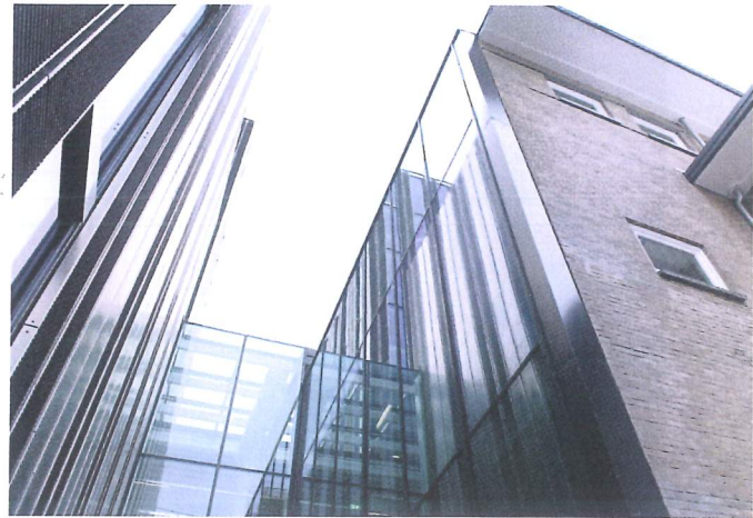
De nieuw gebouwde middenzone van het pand vormt het hart van het gebouw. Aluminium roosters geven het pand een robuust en industrieel karakter.
