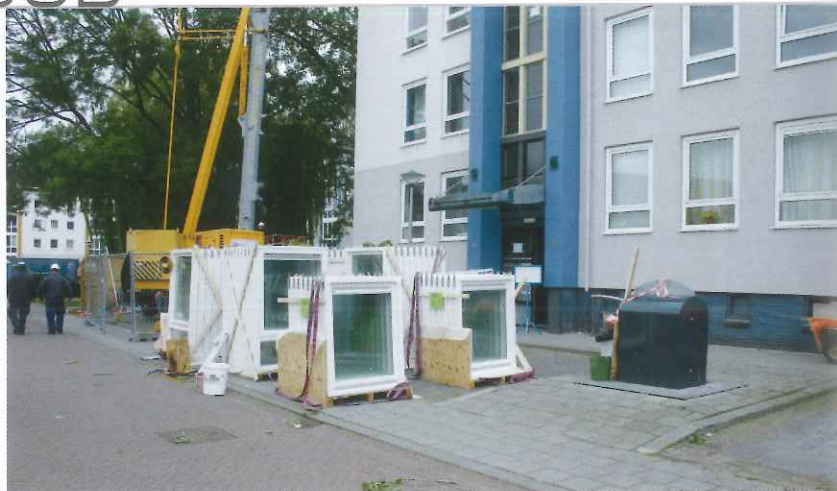
▲ De kunststof kozijnen zijn vervangen door houten kozijnen volgens het Concept 3-principe. Deze kozijnen zijn door de fabrikant beglaasd met HR++ glas, afgelakt en geplaatst.
